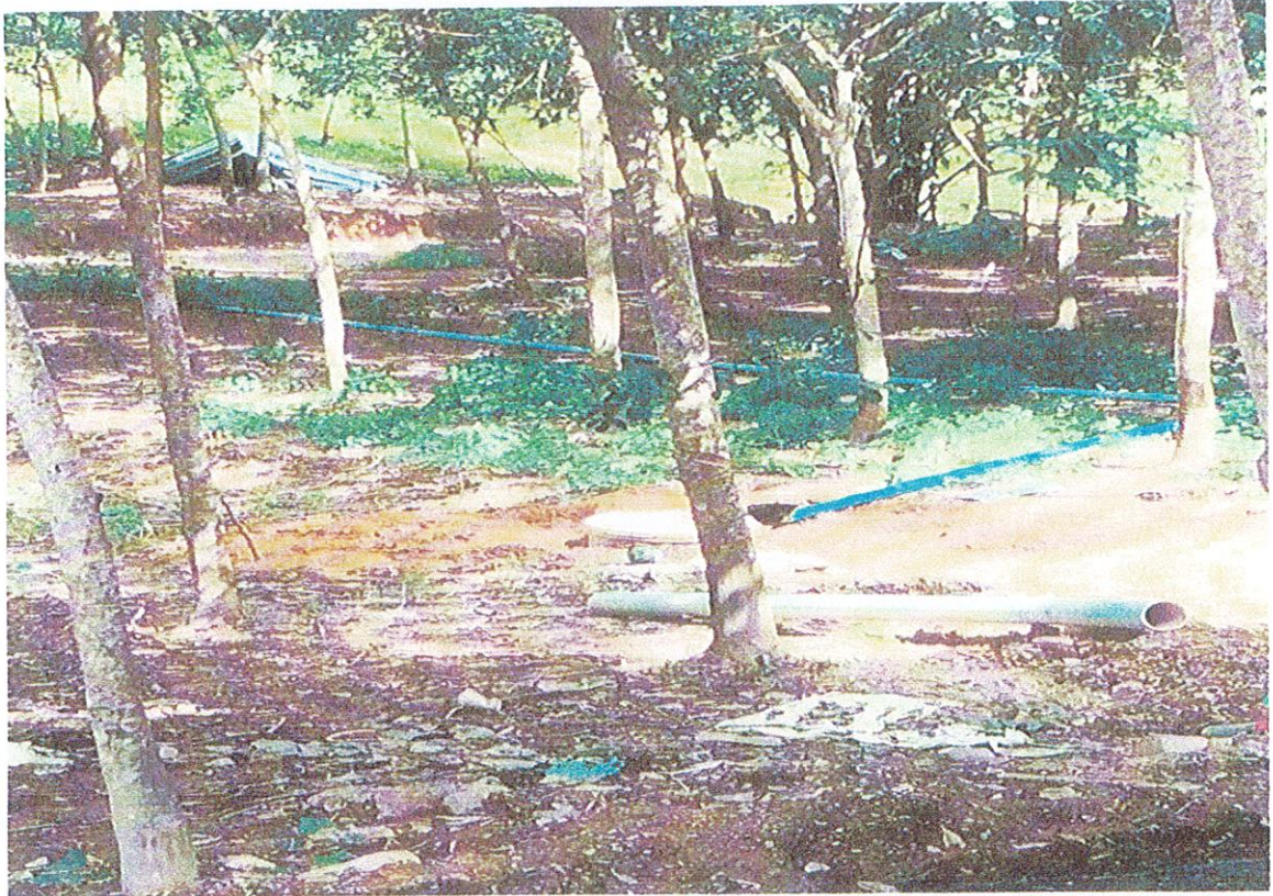
ภาพถ่ายบ่อพักและการกำจัดน้ำเสียลานรับซื้ออย่างกอนถั่ว (คุ้มโนนป่ายาง ม.๙)
