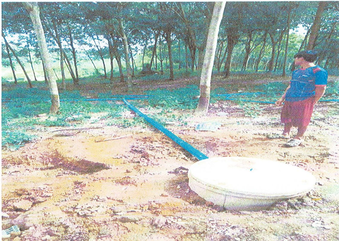
ภาพถ่ายบ่อกักและการกำจัดน้ำเสียลานรับซื้ออย่างกอนถั่วย (คุ่มโนนป่ายาง ม.๙)
